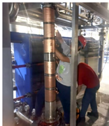
Installation Vulcan sur la machine à malter n° 1 : Conduite Ø DN150, débit 75 t/h, eau à 7 °C, moût à 95 °C
