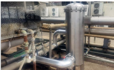
Installation sur la conduite d'eau de refroidissement du compresseur d'air : Tuyau Ø DN150, débit 50 t/h, température de l'eau à température ambiante
