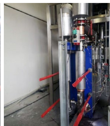
Installation Vulcan sur la machine à malter n° 2 : Conduite Ø DN150, débit 75 t/h, eau à 7 °C, moût à 95 °C
