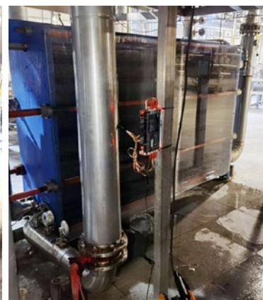
Installation Vulcan sur la machine à malter n° 1 : Conduite Ø DN150, débit 75 t/h, eau à 7 °C, moût à 95 °C
