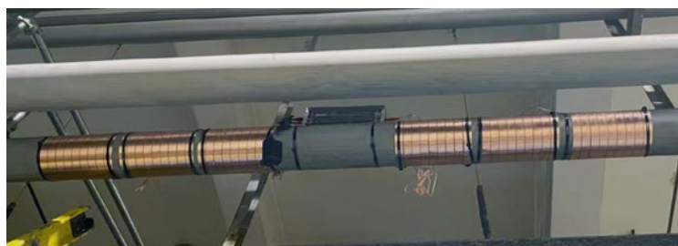
Installation sur la conduite d'eau de refroidissement du compresseur d'air : Tuyau Ø DN150, débit 50 t/h, température de l'eau à température ambiante
